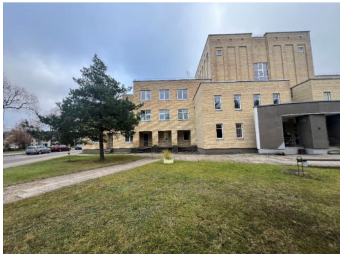
Fotofiksacija pv.1 būklės įvertinimui.
