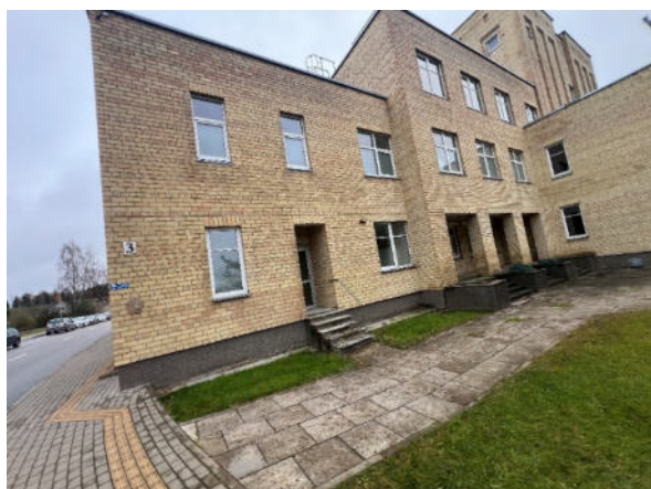
Fotofiksacija pv.2 būklės įvertinimui.
